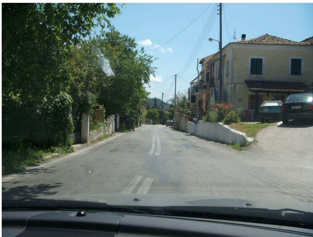
Εικ. 43. Τμήμα «Μωραϊτικά» - «Λευκίμμη»: Διέλευση από το χωριό «Αργυράδες» - χαρακτηριστικό τμήμα της χάραξης
