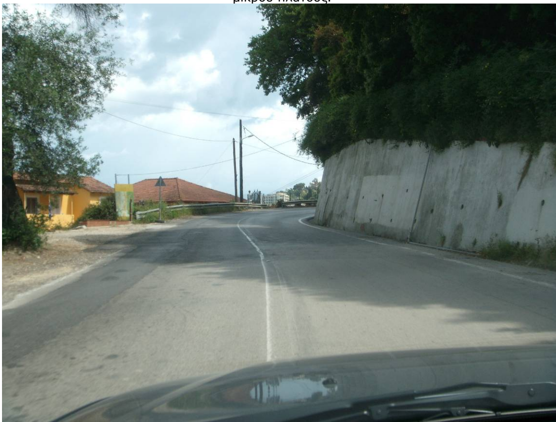
Εικ. 31. Τμήμα «Βρυώνη» - «Πέραμα» - «Μπενίτσες»: Καμπύλη μικρής ακτίνας με ανεπαρκή ορατότητα.
