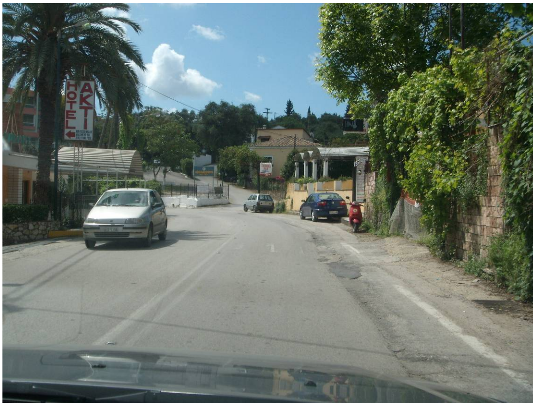
Εικ. 32. Τμήμα «Βρυώνη» - «Πέραμα» - «Μπενίτσες»: Καμπύλη μικρής ακτίνας με ανεπαρκή ορατότητα.
