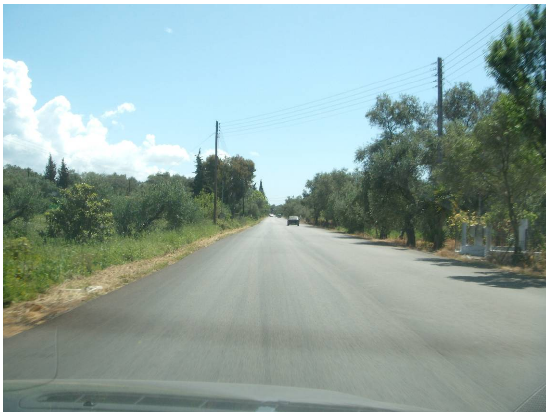
Εικ. 41. Τμήμα «Μωραϊτικά» - «Λευκίμμη»: Τμήμα οδού με σχετικά καλύτερη χάραξη.
