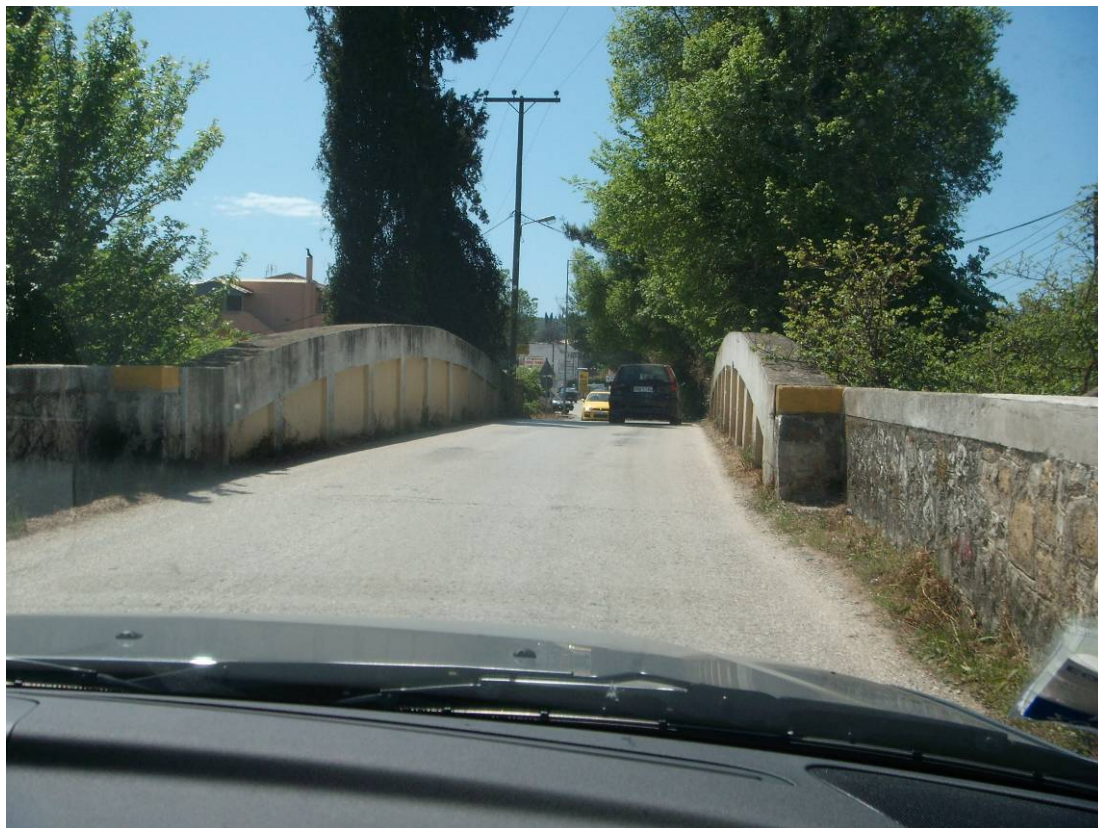
Εικ. 40. Τμήμα «Μωραϊτικά» - «Λευκίμμη»: Στενή γέφυρα
