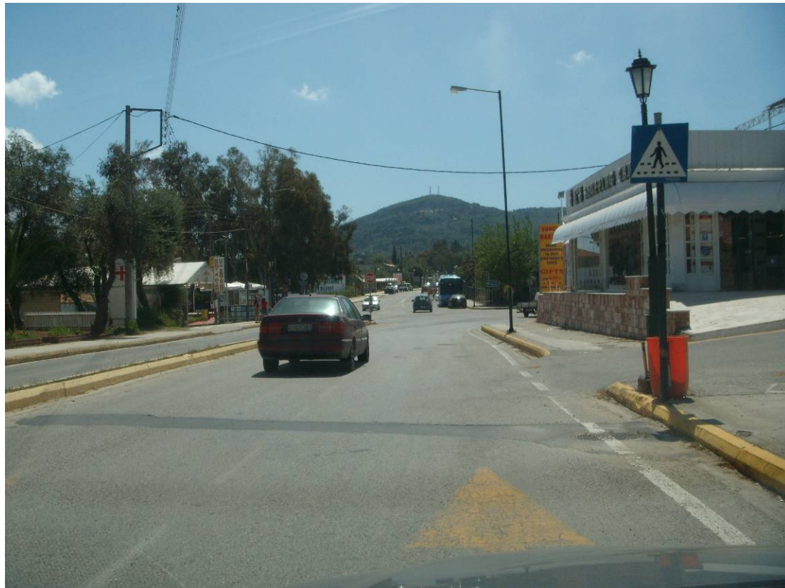
Εικ. 39. Διασταύρωση προς Λευκίμμη: Ανεπαρκή γεωμετρικά χαρακτηριστικά – έλλειψη διαμόρφωσης ισόπεδου κόμβου
